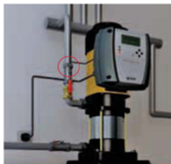
Na instalacji po stronie tłocznej pompy
